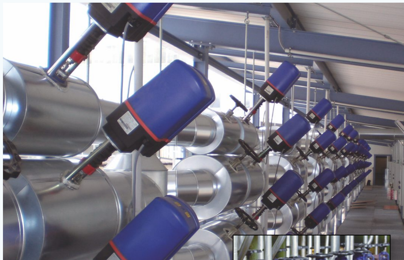
Planta de pisos cerâmicos em Breisach (vapor a 16 bar e 230 °C)
