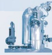
Tanque de água de alimentação com domo desaerador
